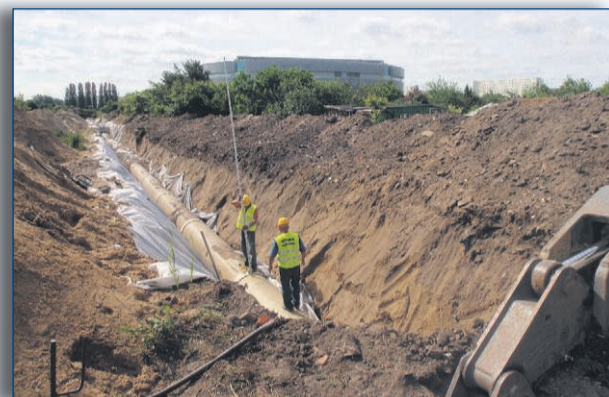
Budowa kanalizacji sanitarnej Sopot-Gdańsk. Widok na Halę Widowiskowo-Sportową
