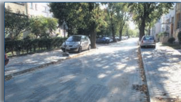
Ulica Karlikowska po zakończonej budowie i modernizacji sieci wod.-kan. 2011 r.
