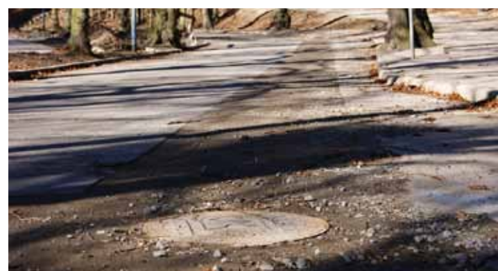
Przebudowa kanalizacji sanitarnej w ul. Moniuszki.
