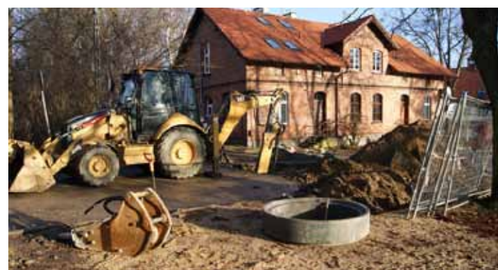
Przebudowa kanalizacji sanitarnej w ul. 1 Maja.
