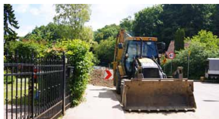
Budowa sieci kanalizacji sanitarnej w ul. Księżycowej
