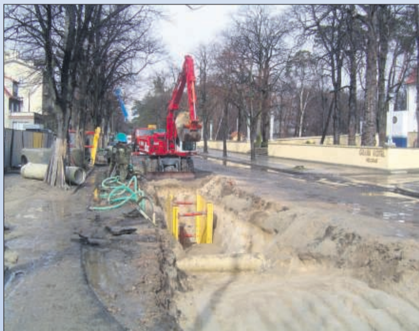
Przebudowa kanalizacji sanitarnej w ul. Powstańców Warszawy w 2008 r.
