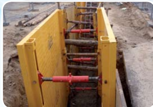
Budowa kanalizacji sanitarnej na skrzyżowaniu ul. Polnej i Łokietka
