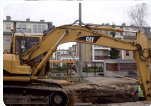
Budowa kanalizacji sanitarnej w ul. Łokietka
