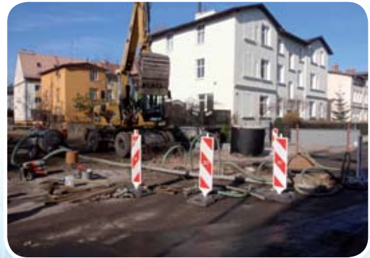
Prace odwodnieniowe przed rozpoczęciem wykopów w rejonie ul Karlikowskiej i Okrzei
