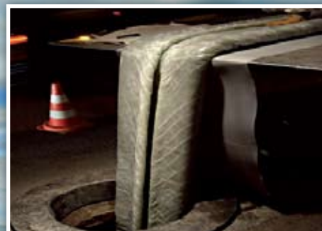
Wprowadzanie rękawa do kanału sanitarnego
