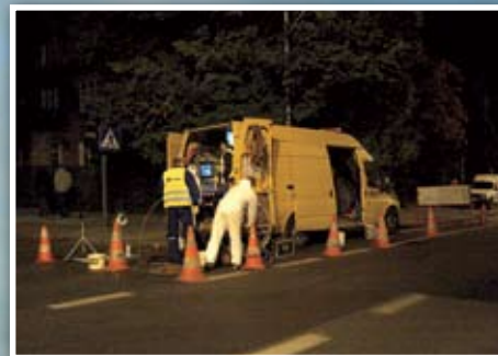
Inspekcja TV kanału w ul. Malczewskiego po renowacji
