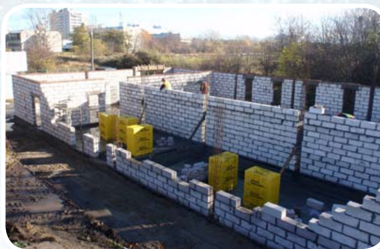
Przebudowa i rozbudowa stacji i ujęcia wody "Bitwy pod Płowcami" w Sopocie
