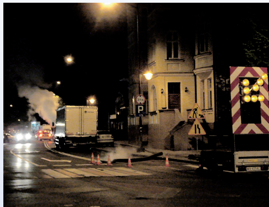
Uszczelnianie kanalizacji sanitarnej metodą bezwykopową w ulicy Grunwaldzkiej.
